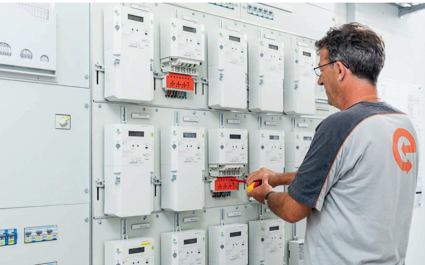
Dank des flächendeckenden Einbaus von Smart Metern braucht es für die Umschaltung zwischen Hoch- und Niedertarif keine Rundsteuerung mehr.
